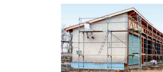
2011 - 2012 ERWEITERUNG / SPIEGELUNG DER DRIVING RANGE Bau ab Herbst 2011 und Eröffnung am 24.05.2012
