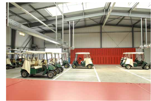
2006 - 2007 BAU E-CART-HALLE OPELSTRASSE 28 Herbst 2006 bis April 2007
