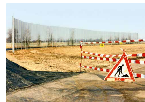
1995 BAUBEGINN GOLFFANLAGE ST. LEON-ROT Platz Rot, Kurzplatz, Driving Range 1, Übungsbereiche, Außengestaltung Clubhaus, Caddiehallen, Eingangsbereich, Parkplätze, Kinderspielplatz, öffentliches und clubinternes Wegenetz, Brücken über Kehrgraben und Kraichbach Oktober 1995
